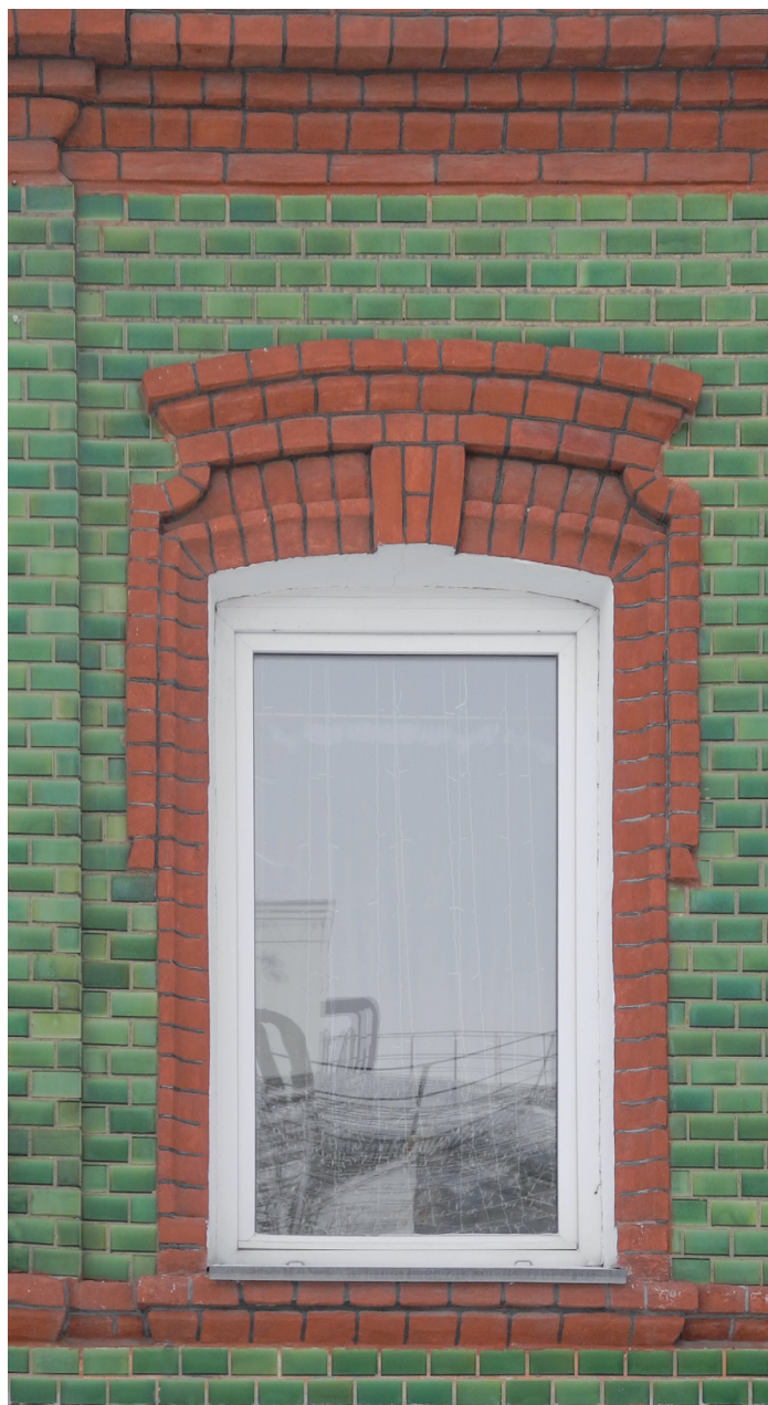
Сформление оконного проема
